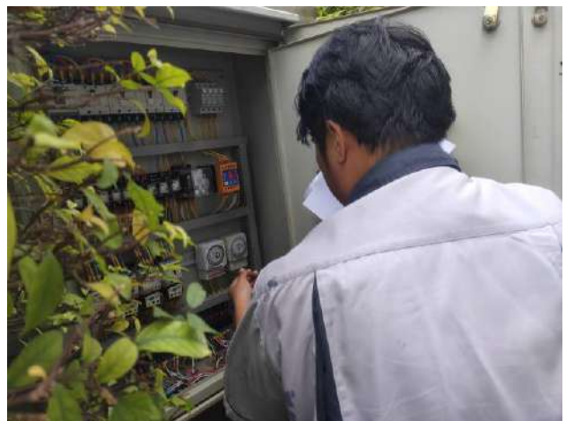
ช่างอาคารฯ ดำเนินการเปลี่ยนไทมเมอร์ (Timer) บั้มเติมอากาศที่ชำรุด อาคาร A
