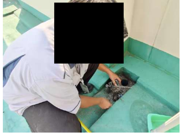
ช่างอาคารฯ ดำเนินการตรวจสอบและทำความสะอาดระบบระบายน้ำดาดฟ้า
