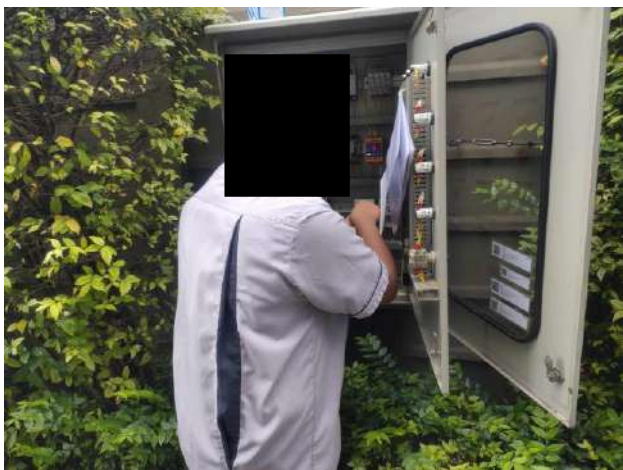
ช่างอาคารฯ ดำเนินการเปลี่ยนไทมเมอร์ (Timer) บั้มเติมอากาศที่ชำรุด อาคาร A
