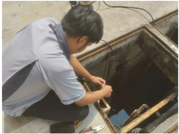
ช่างอาคารฯ ติดตั้ง Sump Pump บริเวณบ่อน้ำเสีย อาคาร A ตัวที่ชำรุด
