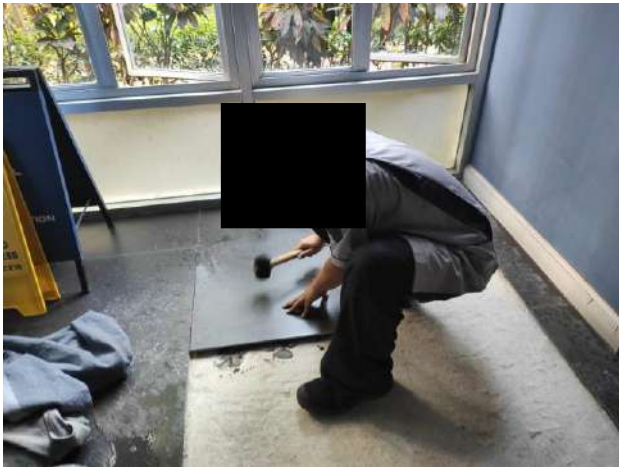
ช่างอาคารฯ ดำเนินการแก้ไขกระเบื้องผนังทางเดินส่วนกลางที่ชำรุด อาคาร B
