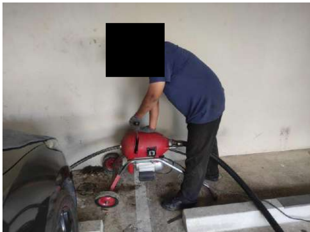
ช่างอาคารฯ ดำเนินการแก้ไขท่อฉีดน้ำดันอาคาร A
