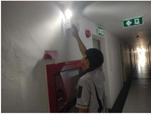
ช่างอาคารฯ ตรวจสอบเช็คถังดับเพลิงและระบบ Emergency light อาคาร A B และ C (ตามแผนงาน)
