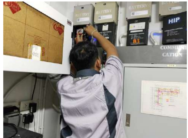
ช่างอาคารฯ ตรวจสอบเช็คการทำงานของระบบ Access Control อาคาร A B และ C
