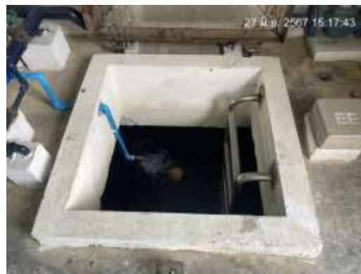
รูปที่ 19 ถังเก็บน้ำใต้ดิน
