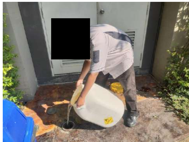
ช่างอาคารเติมจุลินทรีย์ บริเวณบ่อบำบัดน้ำเสีย อาคาร A B และ C
