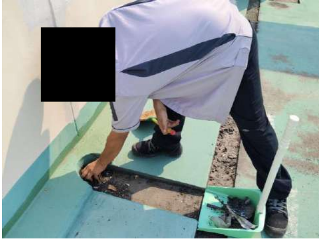
ช่างอาคารฯ ดำเนินการตรวจสอบและทำความสะอาดระบบระบายน้ำดาดฟ้า
