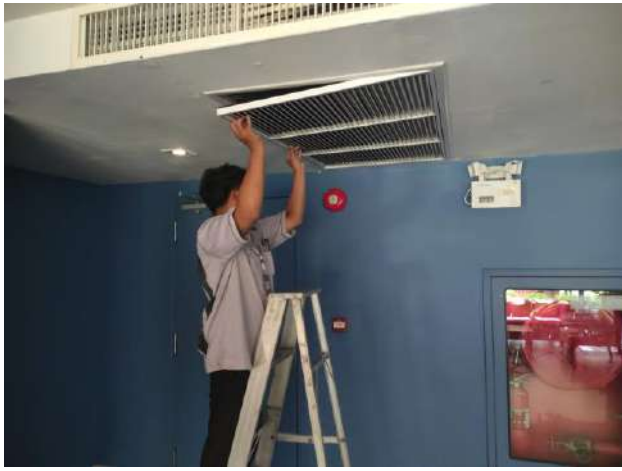
ช่างอาคารฯ ตรวจสอบระบบปรับอากาศ และทำความสะอาดกรองอากาศ บริเวณพื้นที่ส่วนกลาง
