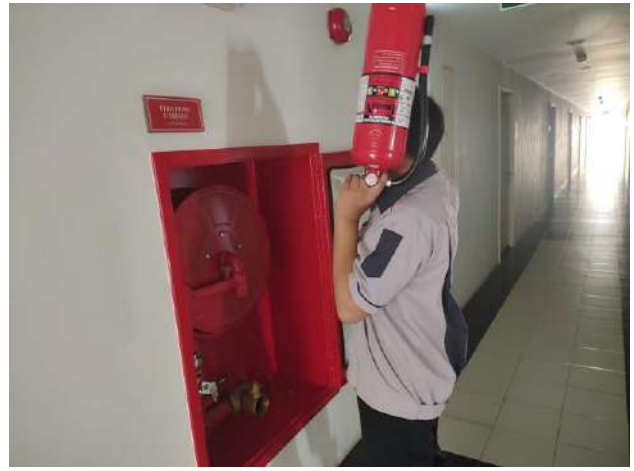
ช่างอาคารฯ ตรวจสอบเช็คถังดับเพลิงและระบบ Emergency light อาคาร A B และ C (ตามแผนงาน)
