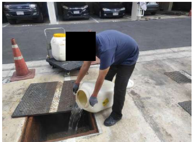
ช่างอาคารเติมจุลินทรีย์ บริเวณบ่อบำบัดน้ำเสีย อาคาร A B และ C
