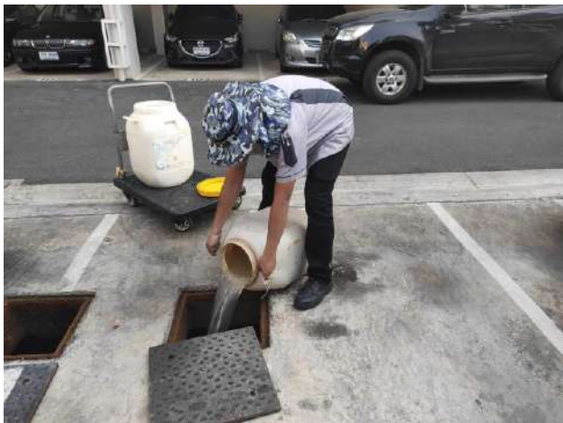
ช่างอาคารฯ เติมน้ำมันทรีบี บริเวณบ่อบำบัดน้ำเสีย อาคาร A B และ C
